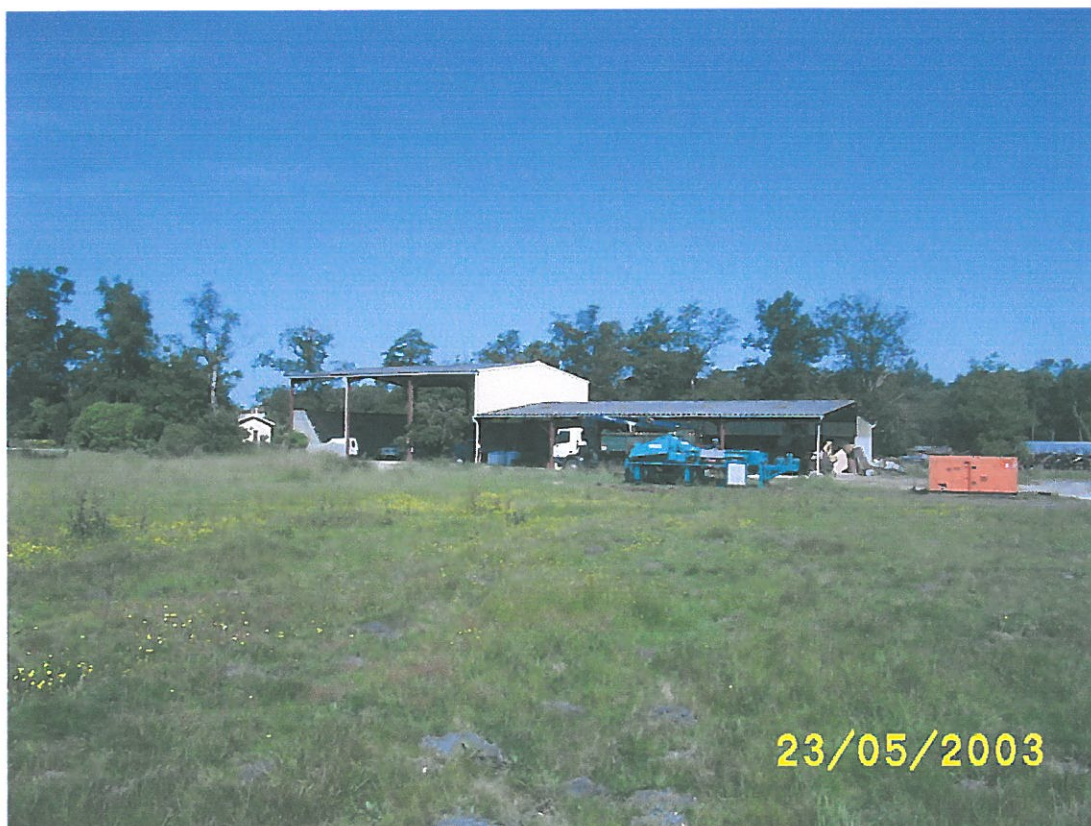
Figure n°6 : Hangar avec broyeur et groupe électrogène au premier plan.
